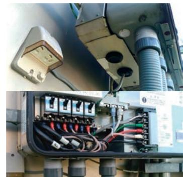
太陽光発電所のパワーコンディショナに設置された非常用電源取り出し口
