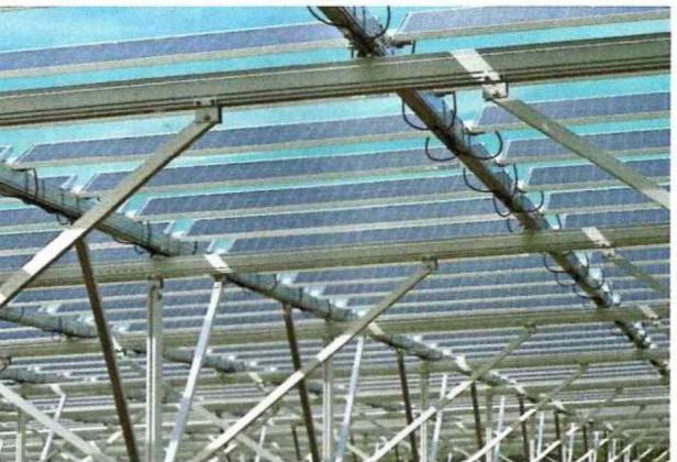
建設中の発電所のパネル。裏側も発電でき反射光や散乱光も拾うので発電効率がアップしている。幅は35cmほどだが、さらに細い20cmほどのパネルも実用化目前だという
