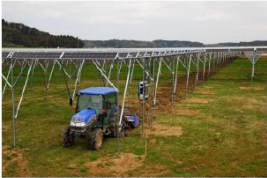
高さのある太陽光パネルの下で大豆や麦を栽培する（千葉県匝瑳市）
